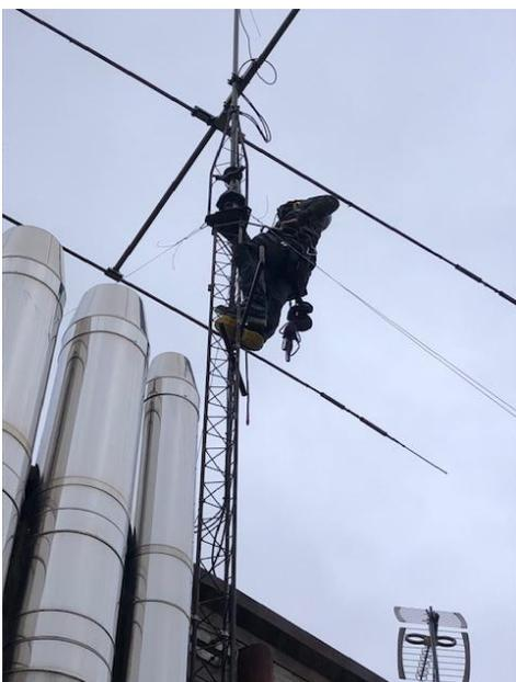
Il traliccio con due sezioni da 4 mt più testata e mast, si è presentato il più difficile fra i due tralicci da smontare, questo perché avremo dovuto lavorare non proprio in sicurezza, visti i pesi, l'altezza ed il traliccio un po' datato.
