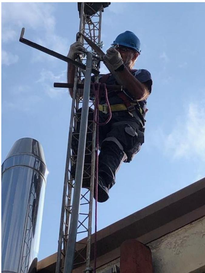
In mezza giornata questo traliccio viene smontato completamente e smontiamo anche il palo dell'antenna filare che era posto sul tetto delle piste da bocce.
